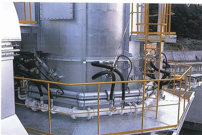
冷却塔上部に配置され冷却塔内部に水を噴霧して排ガスを冷却する装置です。
