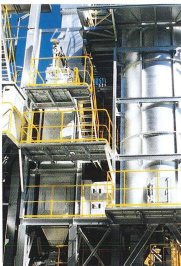
炉の下部から吹き込む空気を100℃前後に暖めて安定した燃焼をさせる設備です。
