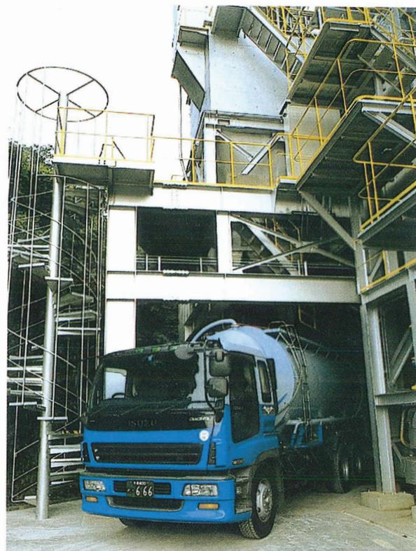
飛灰をセメントの原料にして資源化するための飛灰搬出設備です。
