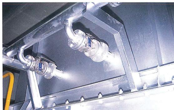
炉の上部で燃焼ガスに新鮮な空気を吹き込み完全燃焼させる装置です。
