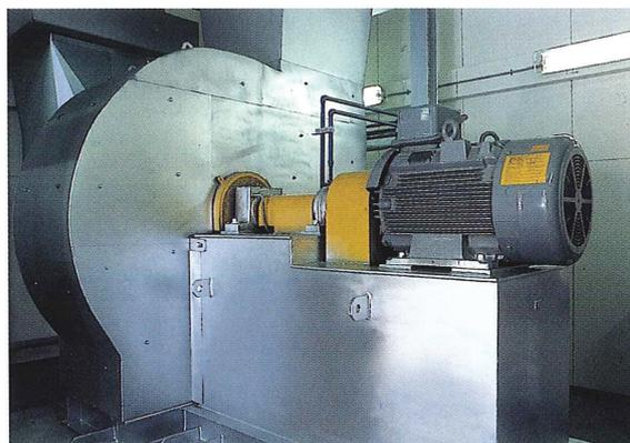
排ガスを炉から引いて煙突に送り込む設備です。
