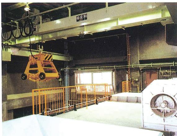
ごみピットから炉へごみを入れるクレーン及び炉の中に燃焼用空気を送り込む押込送風機です。
