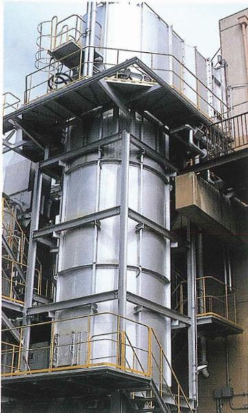
850℃以上の排ガスを200℃以下に冷却しダイオキシンの再合成を抑える設備です。
