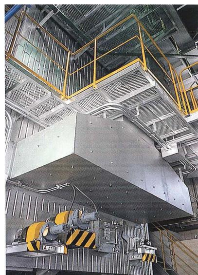
排ガスの中のばい塵や有害ガス類をろ布で完全に捕集する設備です。
