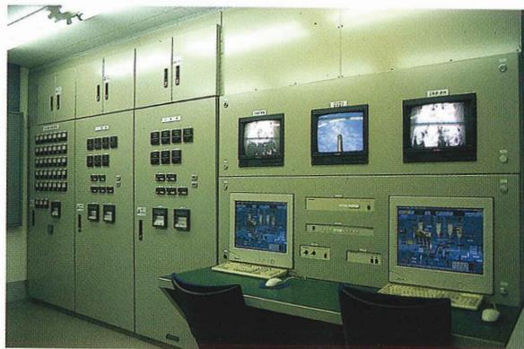
施設の全ての機器類をコンピュータ画面によりコントロール。
