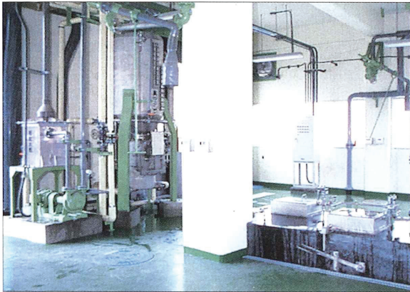
■投入設備・真空除砂装置
